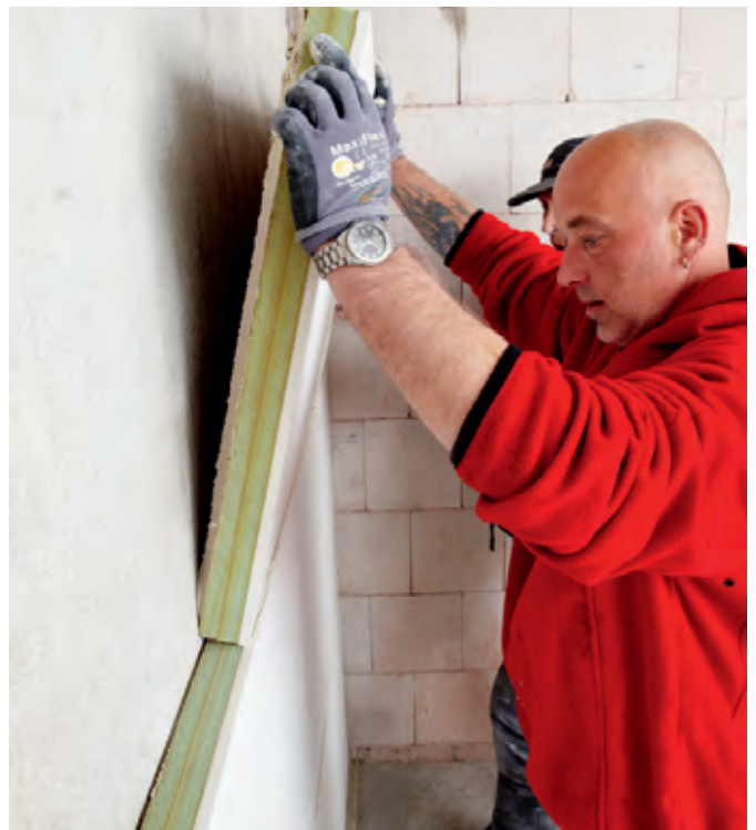
... ließen sich die Platten problemlos auf das für die Klebmontage vorbereitete Mauerwerk verlegen.
